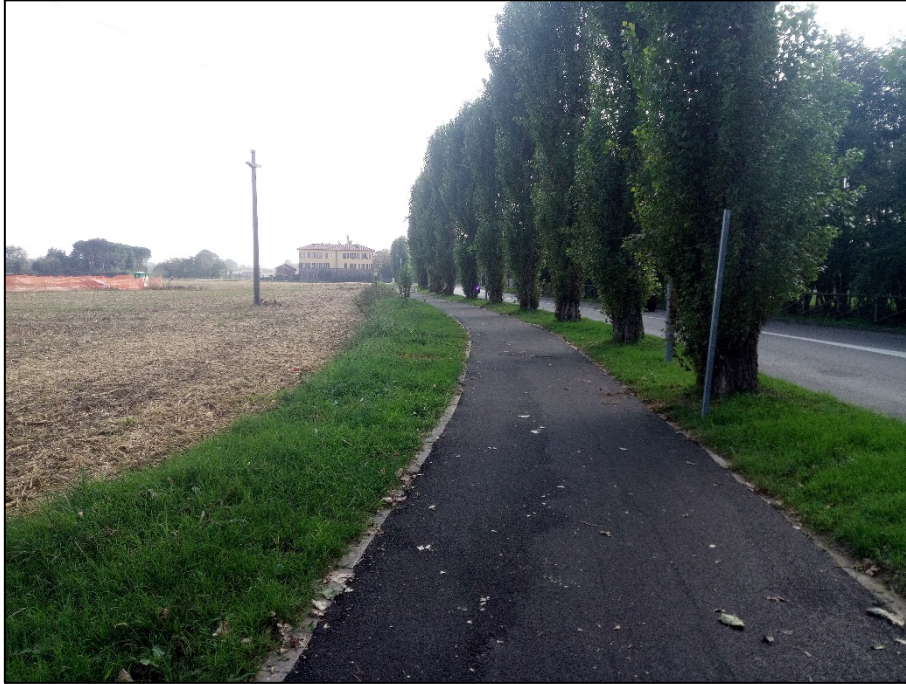
Figura 3: tracciato aereo dismesso di media tensione
