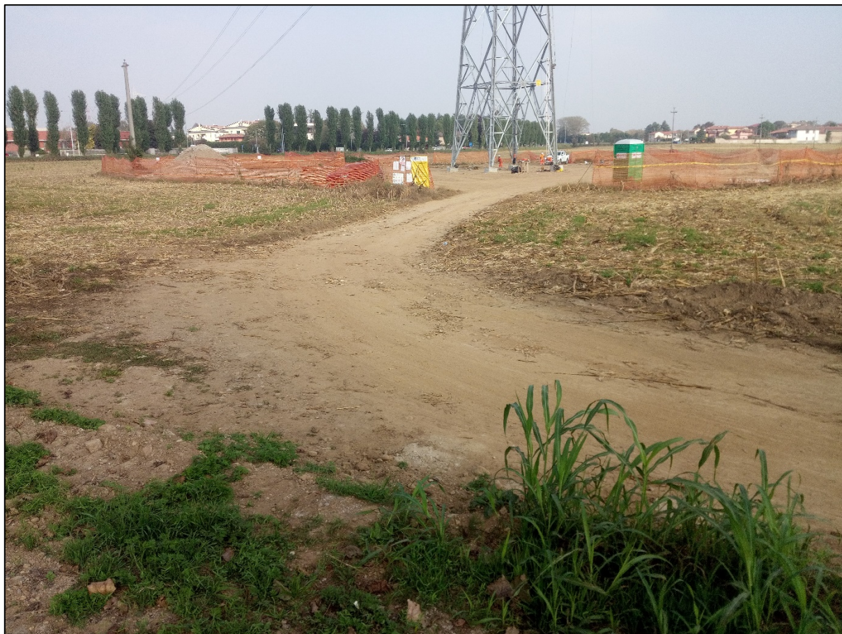
Figura 2: tralicci alta tensione in corso di manutenzione
