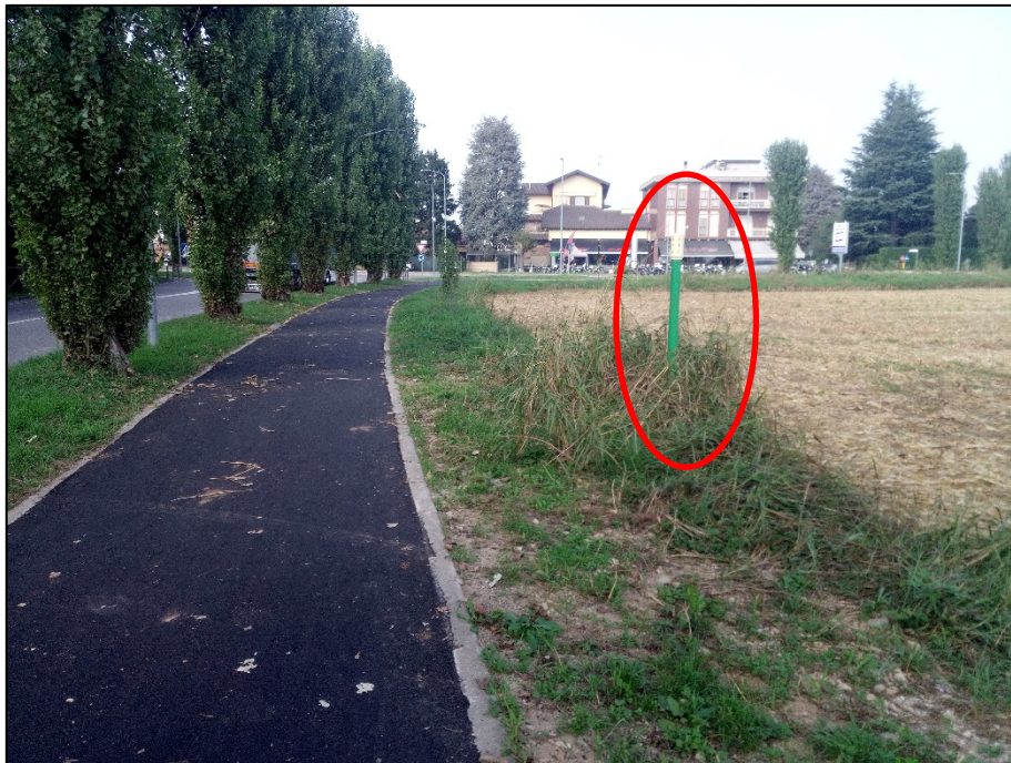
Figura 7: sfiato di rete GAS lungo la pista ciclabile
